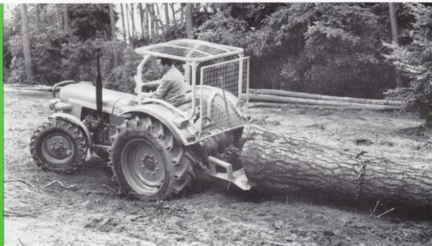
Königstiger Allrad 45 PG — gut zu erkennen die Forstausrüstung der Maschine mit Überschlagschutz und Schutzgitter
