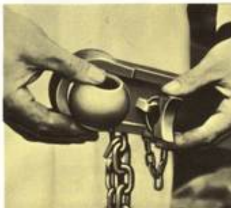
Dreipunktgestänge für Anbaugeräte der Kategorie I und II
