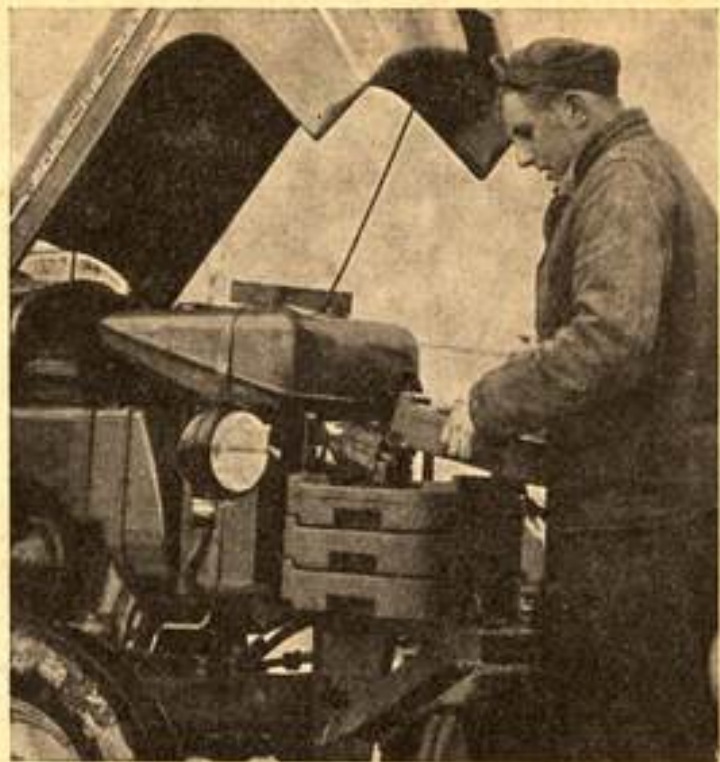
Handliche Zusatzgewichte werden an leicht zugänglicher Stelle des Schleppers schnell ein- oder ausgebaut.
