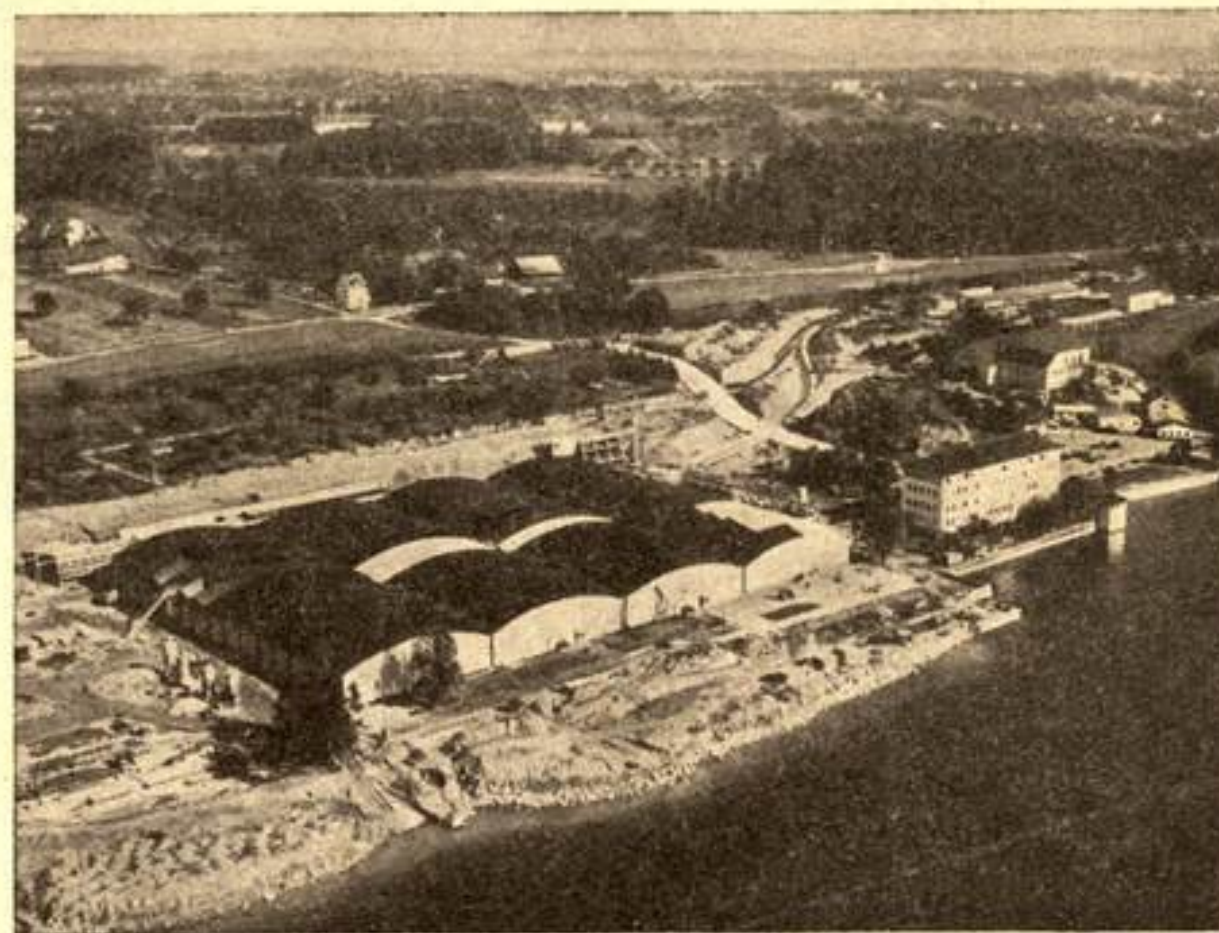
Das neue PORSCHE-DIESEL -Werk in Friedrichshafen a. B.
